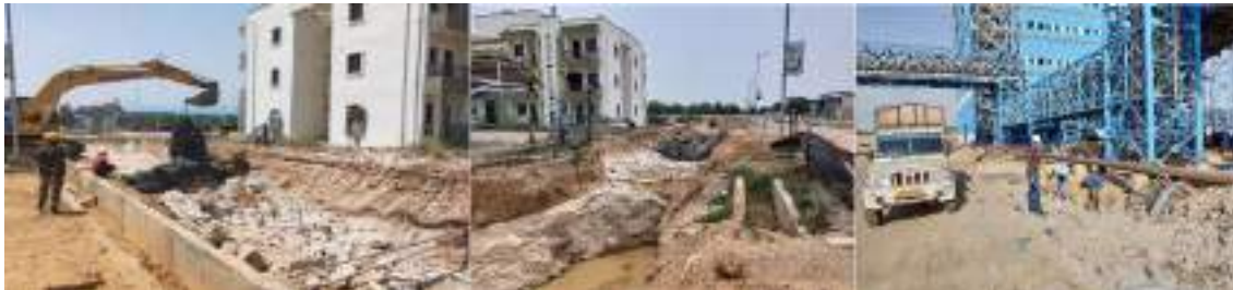
एस.टी.पी.पी. पर एन.टी.पी.सी. दर्लीपल्ली, की स्थायी संरचनाओं के करीब सीवरेज लाइन के लिए फील्ड हॉस्टल के पास नियंत्रित ब्लास्टिंग
