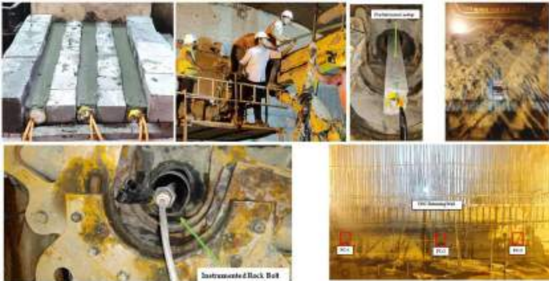
अनुप्रवाह सर्ज चैंबर की बची हुई दीवार पर पार्श्विक धक्के की निगरानी के लिए पूर्वनिर्मित प्रबंध की स्थापना जिसमें लोड सेल और द्विअक्षीय बोरहोल स्ट्रेस मीटर, गिरी हुई मिट्टी में इंस्ट्रुमेंटेड रॉक बोल्ट और प्रेशर सेल शामिल हैं
