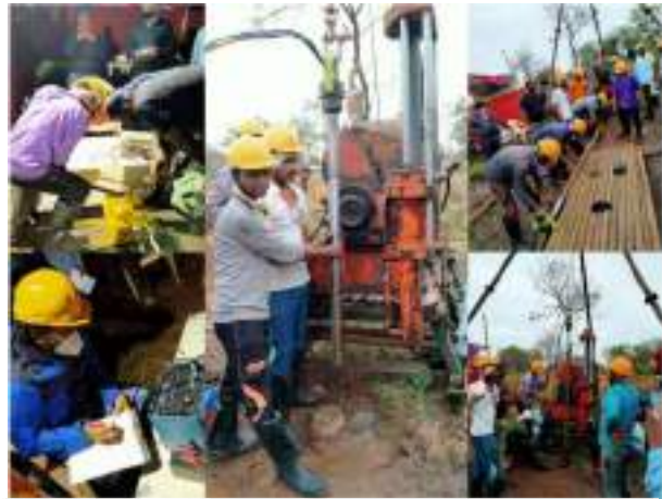
परीक्षण स्थान BH-18 पर गुडमैन जैक परीक्षण प्रगति पर है
