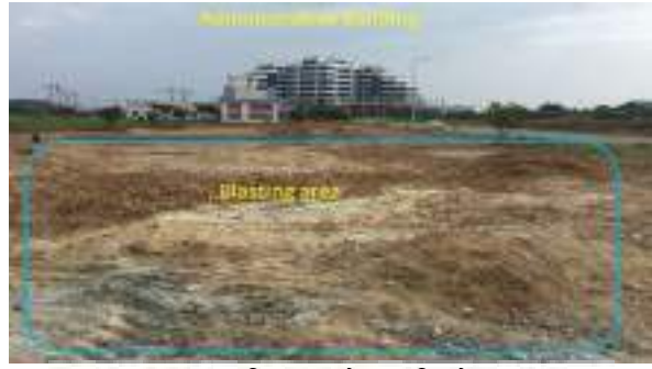
प्रशासनिक भवन के पास विस्फोट
