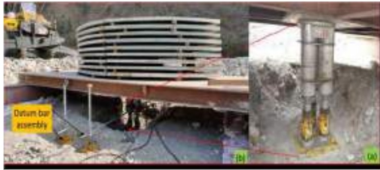
प्लेट लोड टेस्ट (ए) लोड उपकरण (बी) डेटम बार सदन
