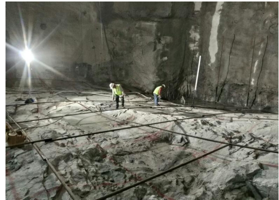
पंप गड्ढे की नींव के संयुक्त डेटा का भूगर्भीय मानचित्रण और संग्रह
