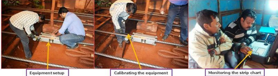
केबल बेल्ट ड्राइव रस्सी, नाल्को का निरीक्षण
